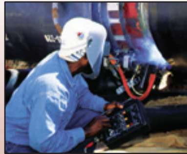
Schweißerarbeiten an einer Dampfleitung Slattery-Projekt, NYC
