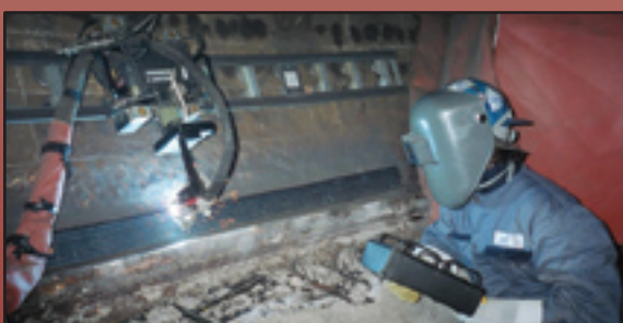
15. 2m (50') Durchmesser, Einrichtung Schweißerarbeiten am Innendurchmesser – Raffinerie, Kanada
